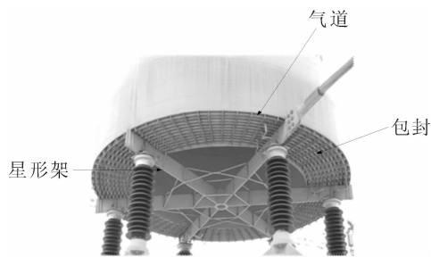
图2 干式空心电抗器结构图
